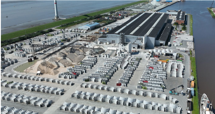
Bildunterschrift: Die neue Max Bögl Fertigungsstätte in Emden Bildnachweis: Max Bögl Wind AG
